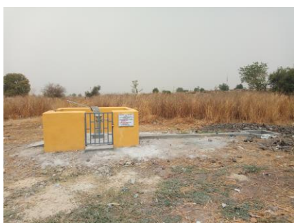
Forage équipé de PMH à Sinassi Mafiré BIP/MINADER2019
