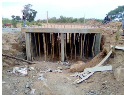
Ouvrage de franchissement sur l'axe Mayo Souwa – Ouro Kessoum
