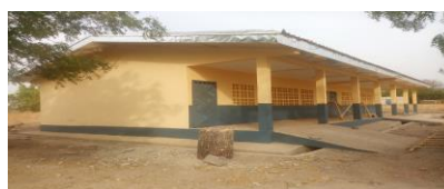
Bloc de 02 salles de classe à EP Homa mal Yaya
