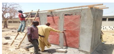
Bloc latrine à EP Batao
